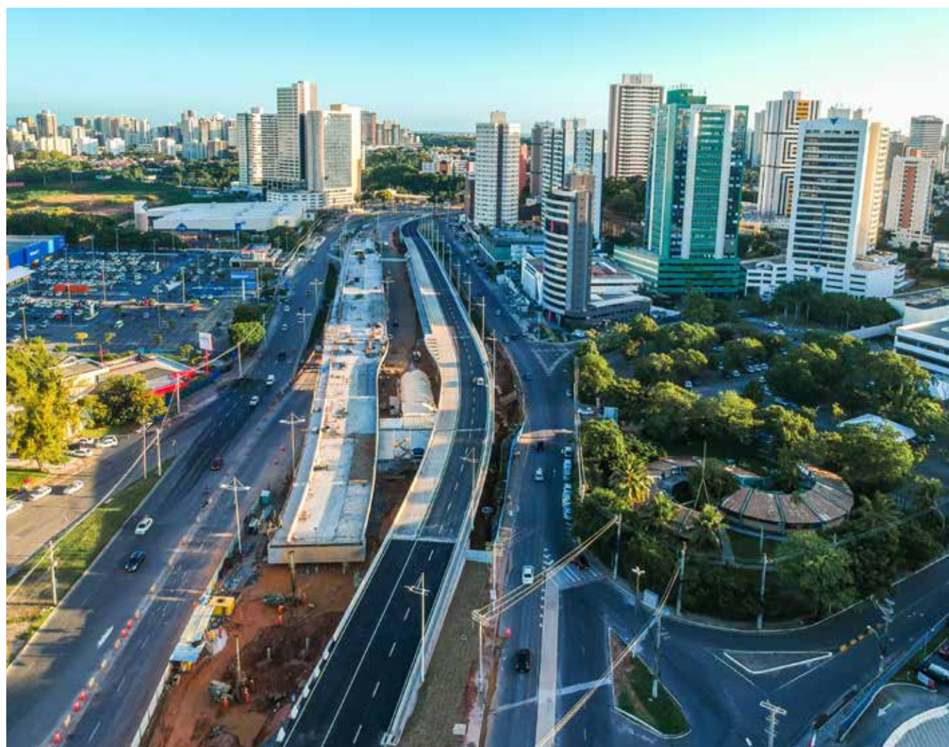
Obras do BRT Salvador
