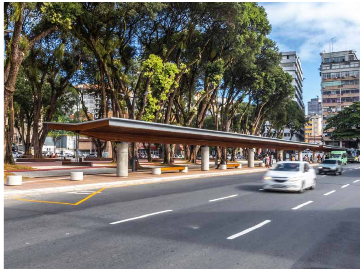
Ponto de Ônibus – Praça Marechal Deodoro
